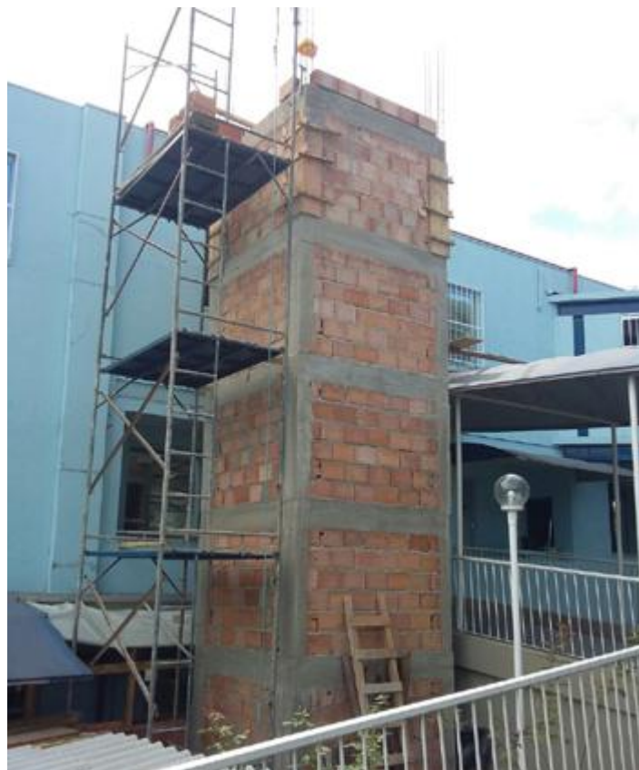
ELEVADOR EM CONSTRUÇÃO
